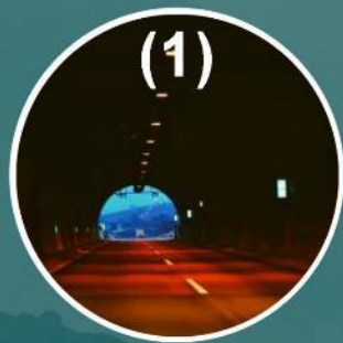
Agua Negra tunnel (1)
